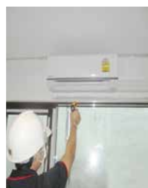
ทดสอบและติดตั้งเครื่องปรับอากาศบริเวณห้องพัก
