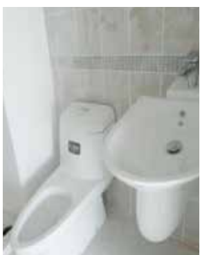
ติดตั้งโถสุขภัณฑ์ บริเวณชั้น18
