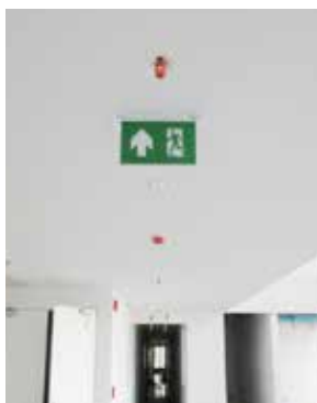
ทดสอบระบบไฟฟ้า และติดตั้งทางออกฉุกเฉิน
