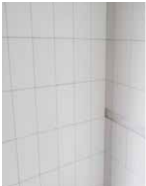
งานกระเบื้องเบื้องห้องน้ำ
