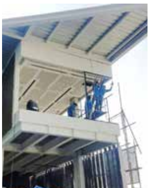
งานโครงสร้างบริเวณพิตเบส
