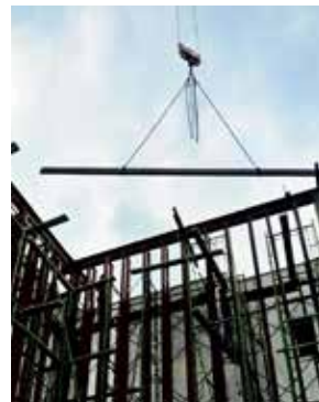
โครงสร้างมังกูอาคาร
