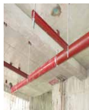
เดินระบบท่อน้ำดื่ม
