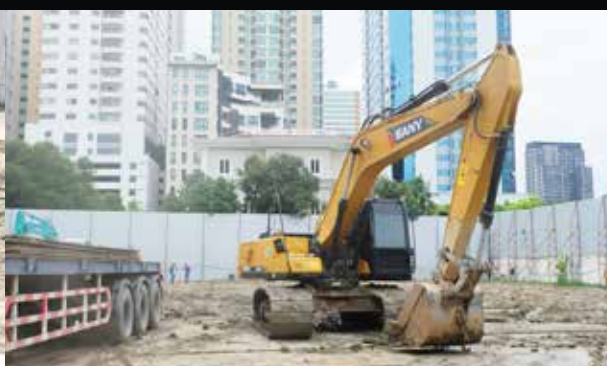
▲ การปรับพื้นที่บริเวณโครงการหลังลงเข็มเสร็จสิ้น
