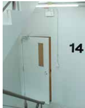
ประตูบันไดหลัก
